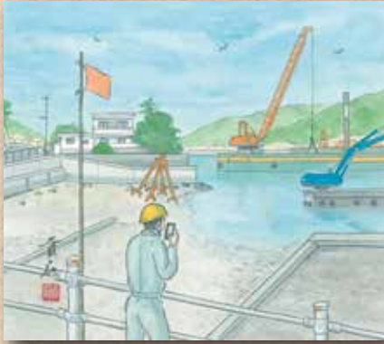
横防 岡崎 貢さんの作品 「宮浦内波止内の工事が始まった」
