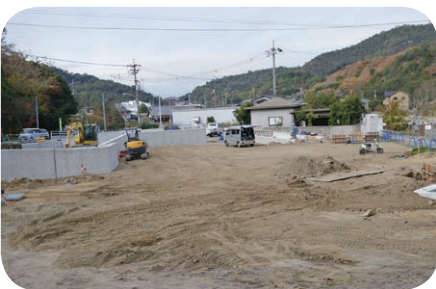
整備が進む第1分団屯所
