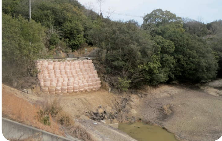
京の山付近の工事現場
