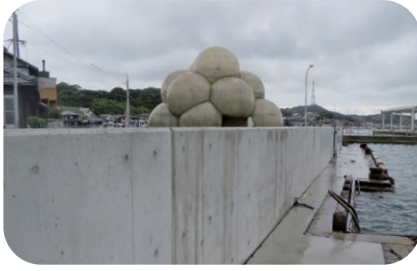
直島港津波対策
