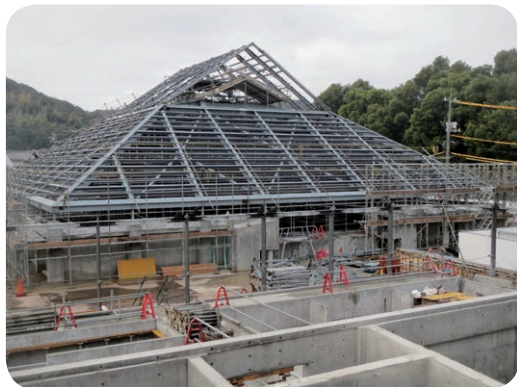
急ピッチで工事が進む町民会館
