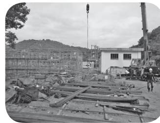
工事中の浄水場
