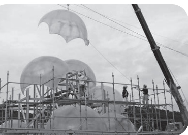
建設中の直島港ターミナル
