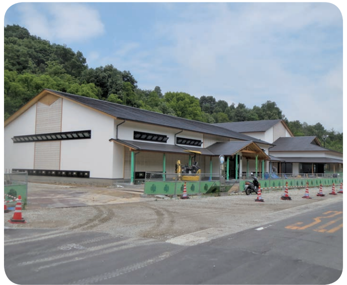
製錬所が建築中の武道場
