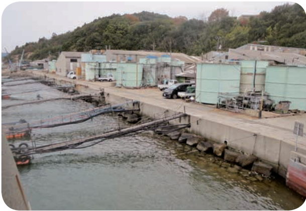
宮ノ浦地震津波対策工事の予定場所
