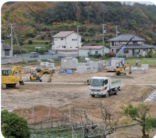
分譲に向け工事中
