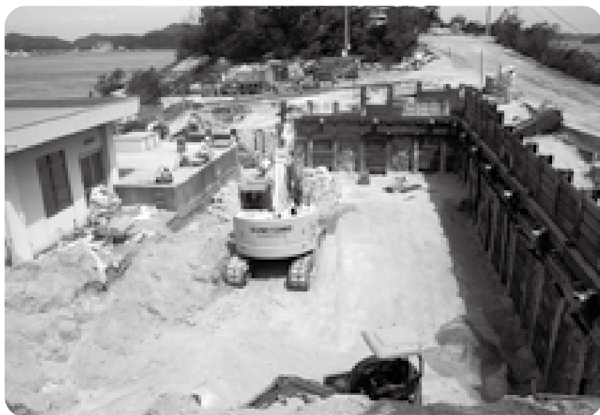
工事中の鶴石受水場
