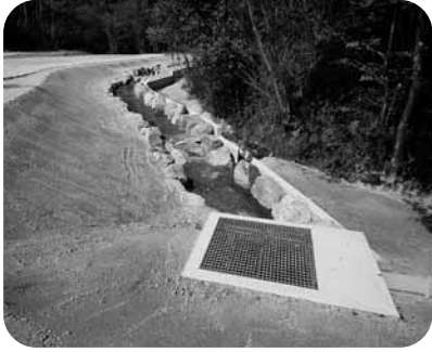
完成したビオトープ
