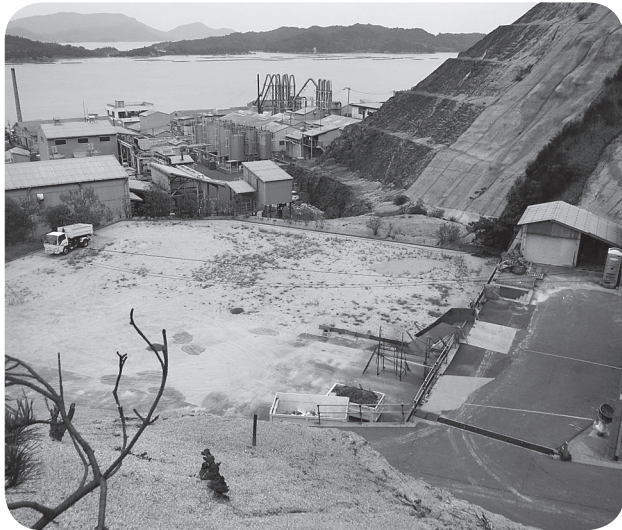
資源化施設建設予定地（本荘ケミカル上）
