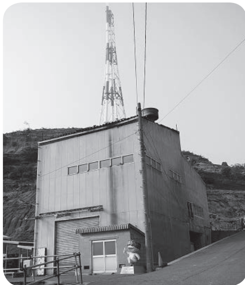
解体する旧焼却施設
