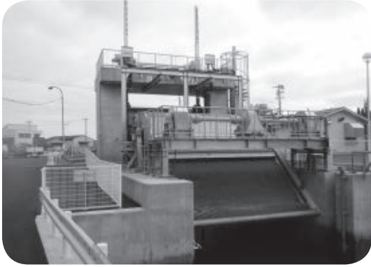
完成した納言様雨水ポンプ場
