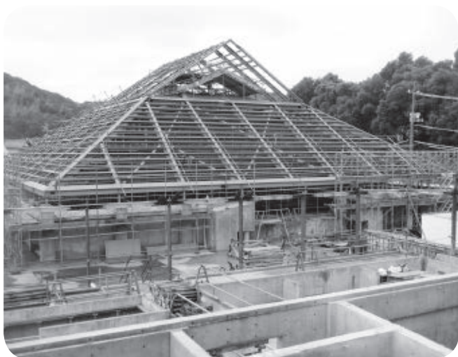
急ピッチで工事が進む町民会館
